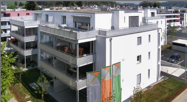
Die im Frühjahr fertiggestellten Mehrfamilienhäuser an der Neugasse 6+8 in Oftringen
