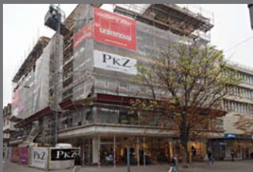
Sanierung der Gebäudehülle der Liegenschaft «Mäderhof» in Baden
